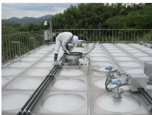
写真：水位計の確認作業
