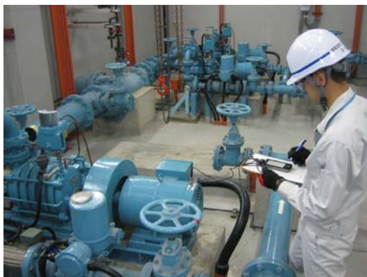
写真：配水ポンプの振動測定作業
