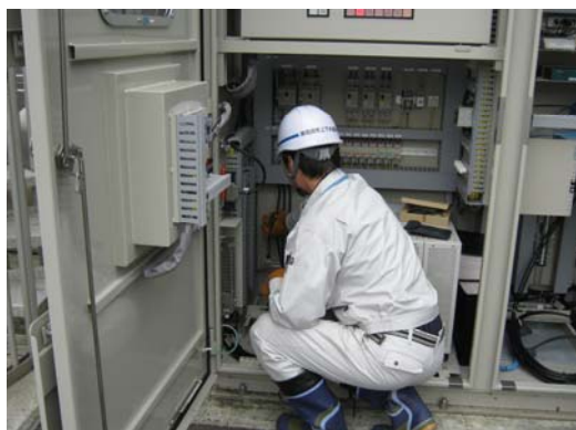
写真：配電盤の点検作業
