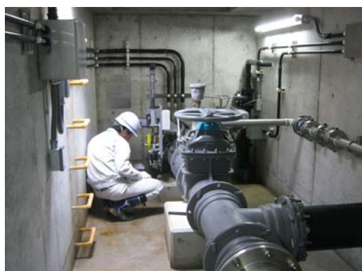
写真：緊急遮断弁*の点検作業
