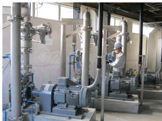
写真：送水ポンプの点検作業
