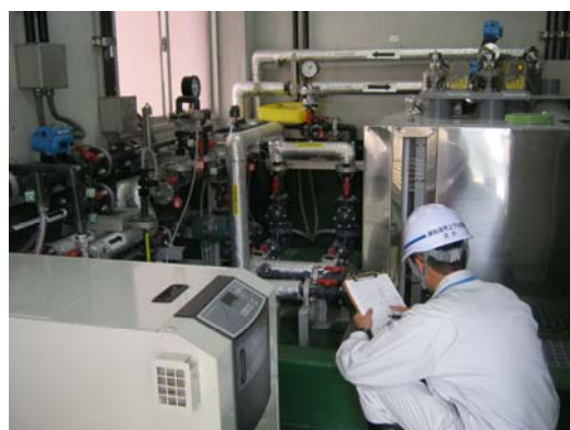
写真：薬品注入機の点検作業
