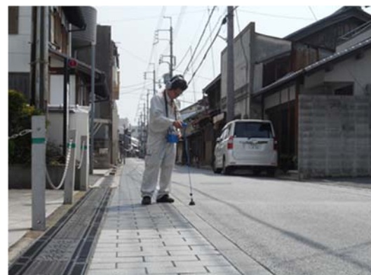
写真：漏水調査の様子
