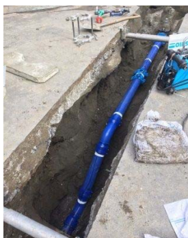
写真：老朽化管路の更新
