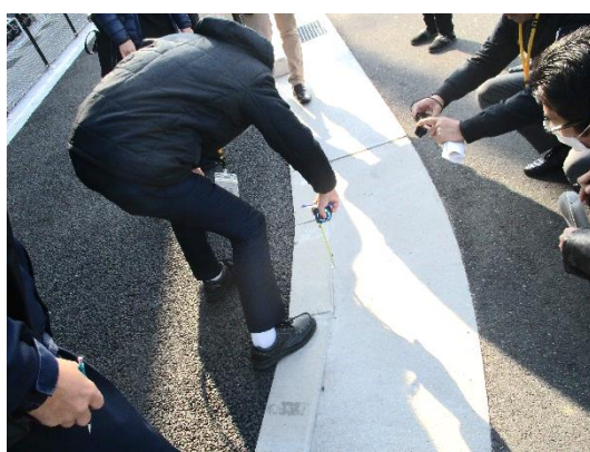
街路の点検②
