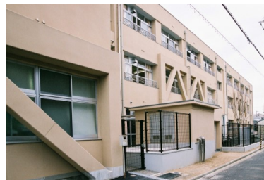
浜小学校耐震改修
