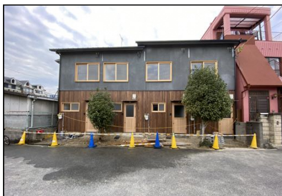
ヨシナガヤ021-工事中(2020)平野区 大阪市耐震補助 大阪市空き家活用補助 昭41年築(築54年)
