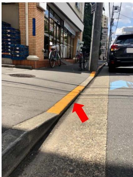
写真 20 車道と歩道の段差 5 cm の例（矢印）
