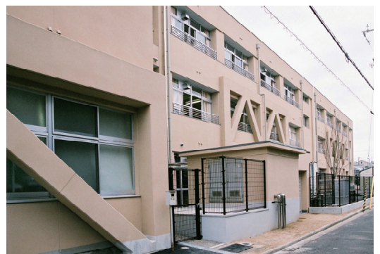
浜小学校耐震改修
