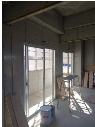
写真 9 訓練棟 1 階内部
