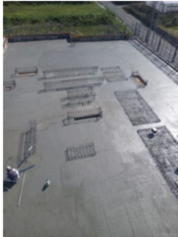
写真 4 消防施設棟屋根
