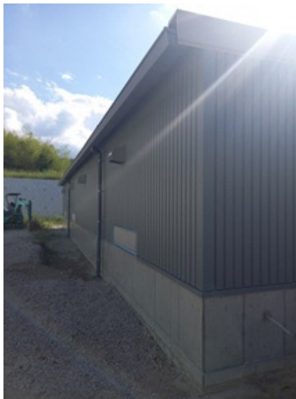
写真 10 防災備蓄倉庫樋、外壁
