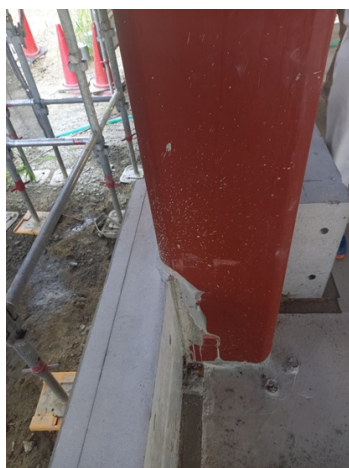
写真6 鉄骨柱脚と腰壁
