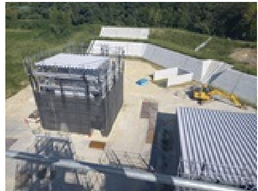
写真 5 訓練棟（左）と倉庫棟屋根
