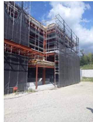
写真 3 消防施設棟正面
