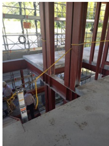
写真8 エレベーター・階段 墜落防止
