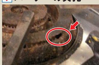
ガスバーナーの炎孔が腐食して、穴がつながっています。
