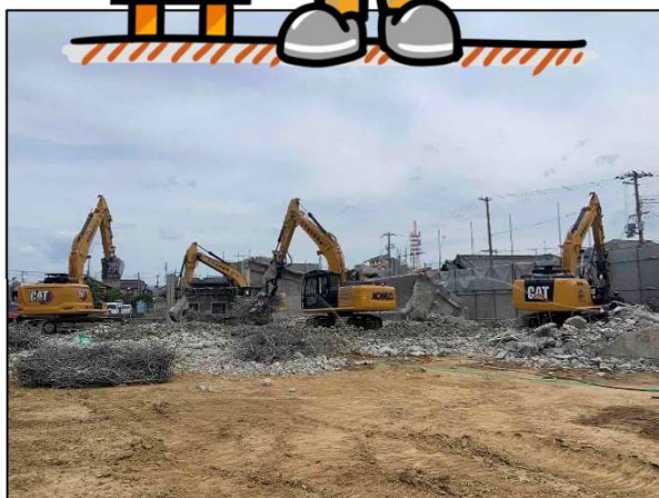
太田幼稚園舎解体
