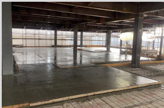
2階内部(コンクリート打設後) R6年10月
