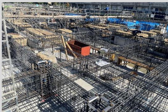
基礎工事① R6年8月
