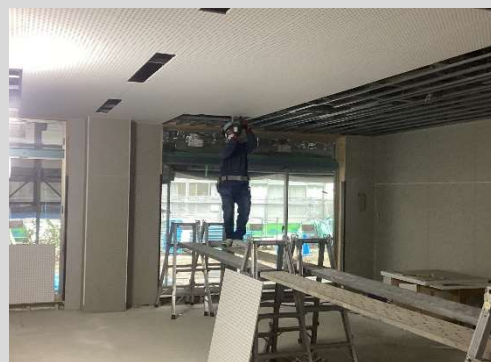
天井ボード施工風景
