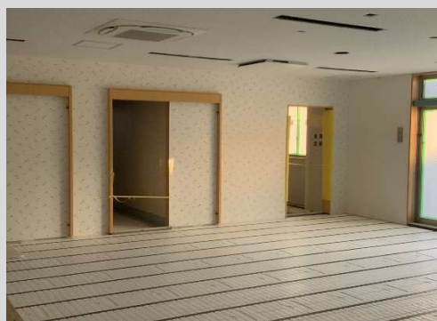
保育室クロス貼り完了
