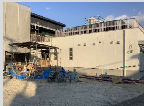
南面足場解体作業完了
