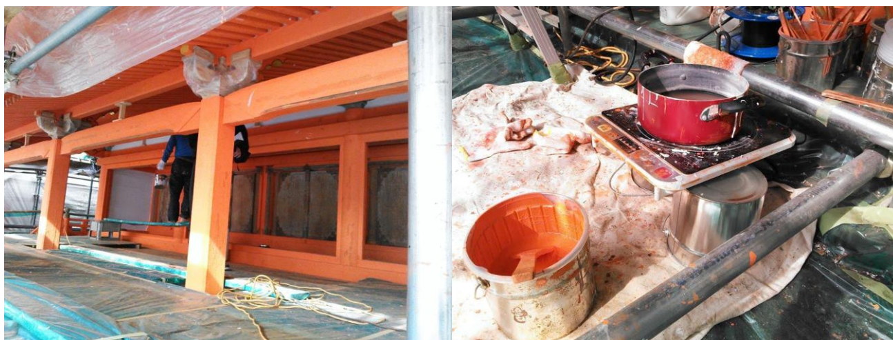
写真 3. 修復中の積川神社（写真左）と煮詰めている鉛丹（写真右）
