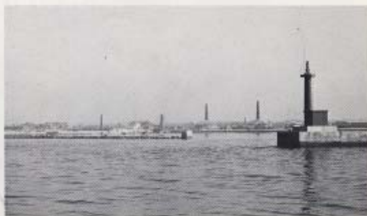
昭和29年2月岸和田港口 右灯台は西防波堤赤灯台。現在岸和田旧港 港口の水門工事のため、撤去される。
