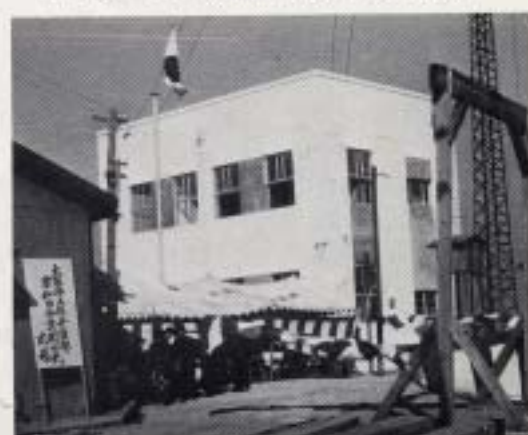
昭和30年12月大阪海上保安監部岸和田分室落成竣工式
