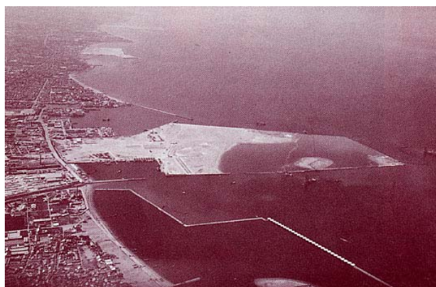
造成中の臨海町
